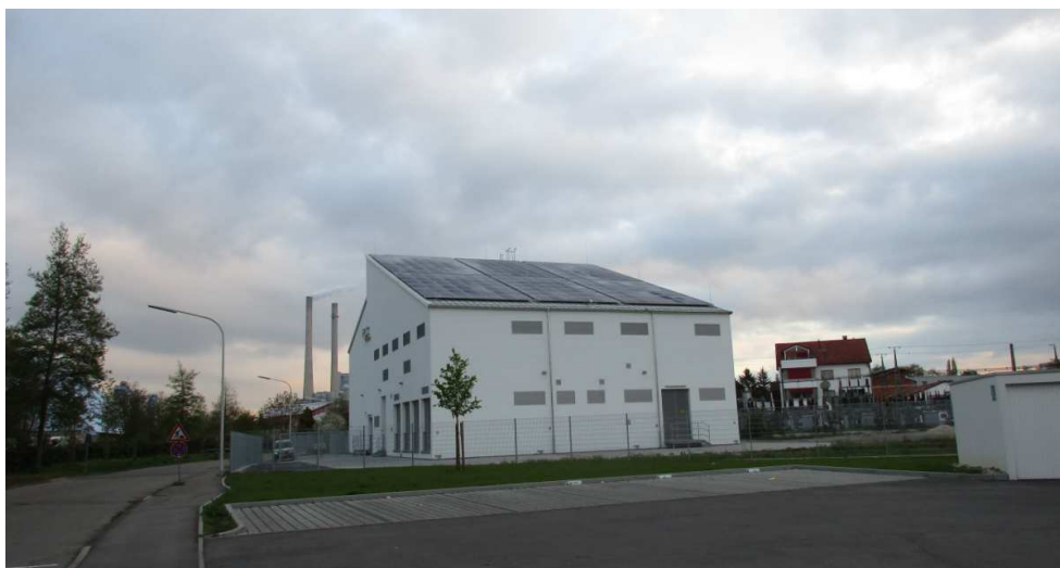
Bild: Umspannwerk Salzwerkplatz
