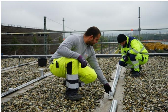
Die angehenden Elektroniker\*innen für Betriebstechnik führten von der Planung bis zur Inbetriebnahme alle Arbeitsschritte selbständig aus. Zunächst musste die Anlage an ihrem alten Standort auf dem Dach der Fritz-Ulrich-Schule abgebaut werden, da die Schule saniert wird. Beim Abbau und Neu-Aufbau der Module war viel Fingerspitzengefühl gefragt, da diese bereits in Betrieb waren. Auch die Montage auf dem Dach des Wartehäuschens
