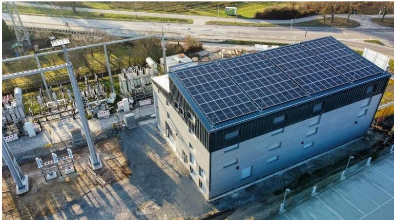
Zusätzlich wurde auf dem Dach eine Photovoltaikanlage mit 74 kWp errichtet.
